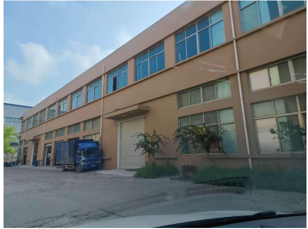
项目所在厂区西侧
